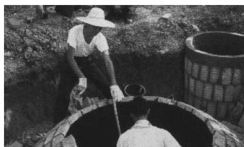
تاسیسات گاز زیستی از نوع گنبد ثابت در حال ساخت در شانگهای، چین
