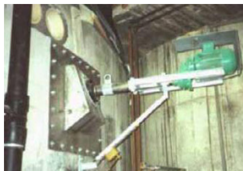
بازوی مکانیکی ویژه هم زدن مخلوط در حال تجزیه در یکی از تاسیسات گاز زیستی در اروپا
